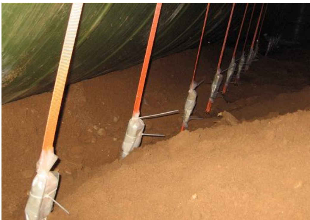
Установка емкости на плите, крепление стяжных ремней
