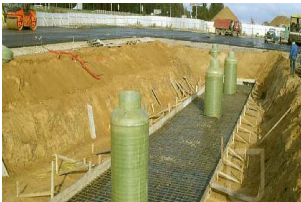
Изготовление распределительной плиты
