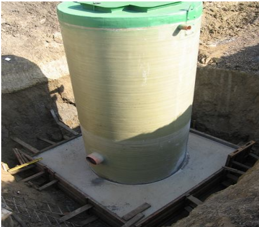
Установка вертикальной емкости, анкерение и бетонирование.
